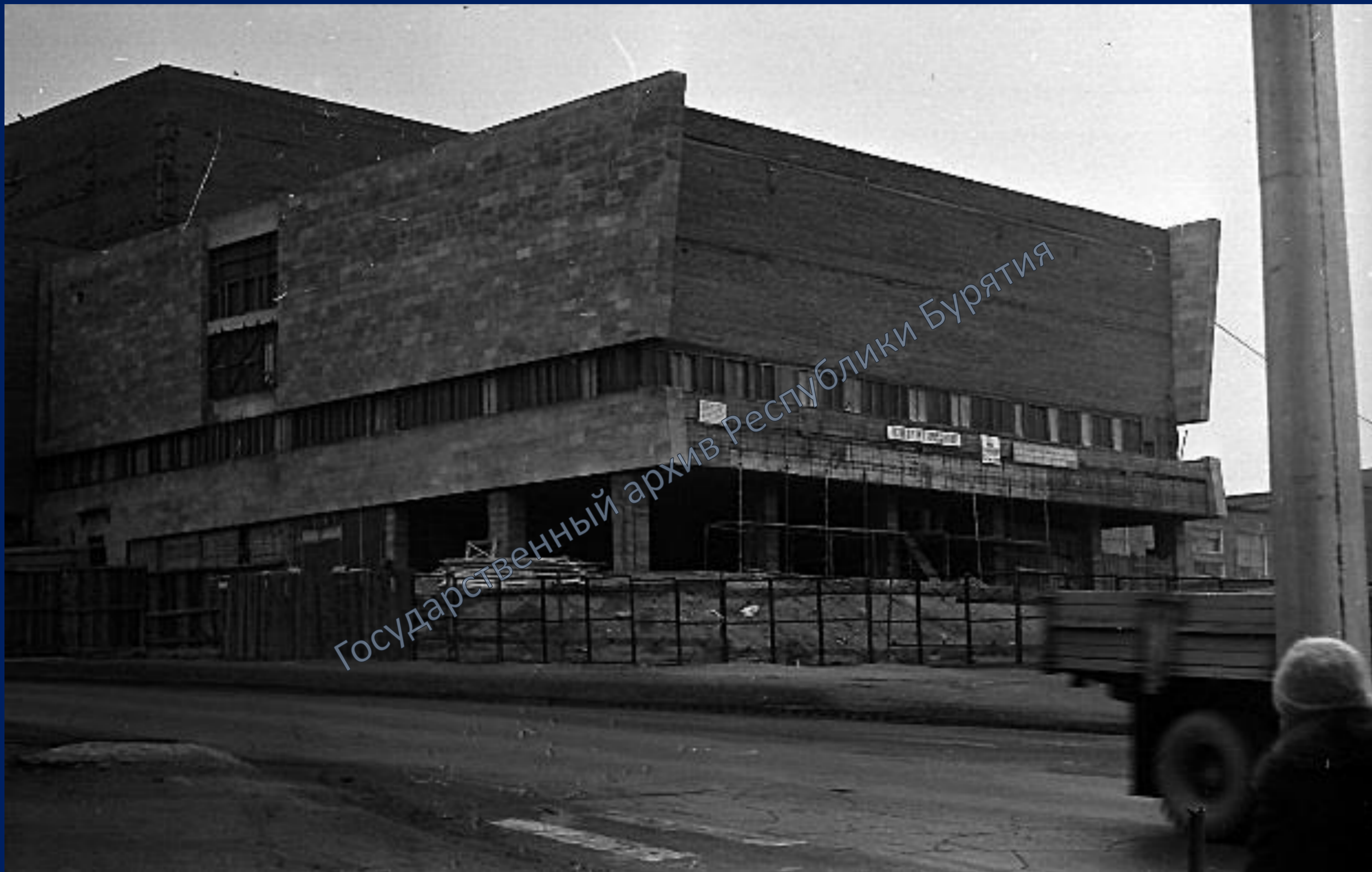
Строительство здания Бурятского драматического театра. Март 1980 г.
