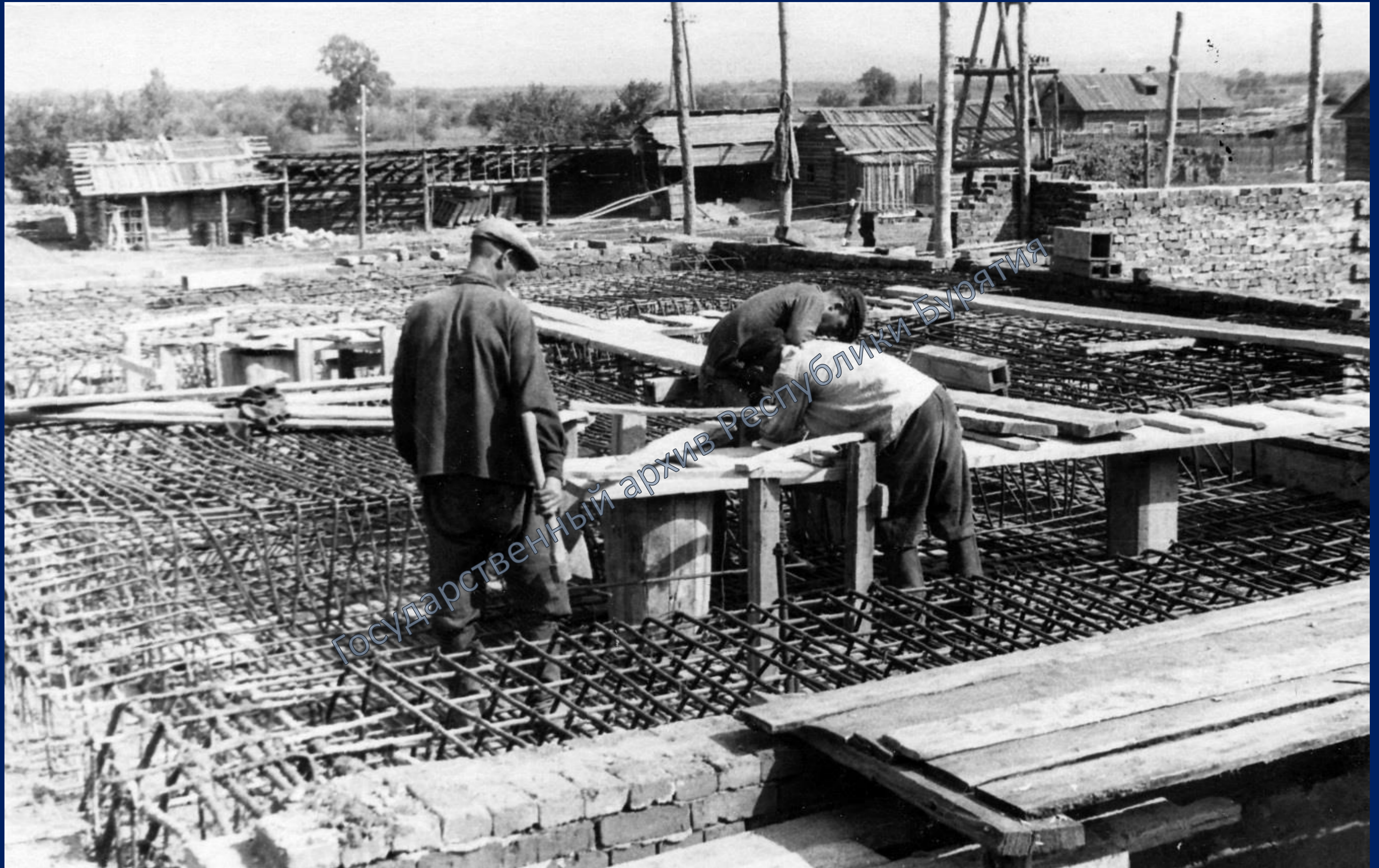
Строительство Тохойской ГЭС. [1955 г.]. Фотофонд ГАРБ
